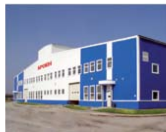
Производственный комплекс BROEN в Коломне
